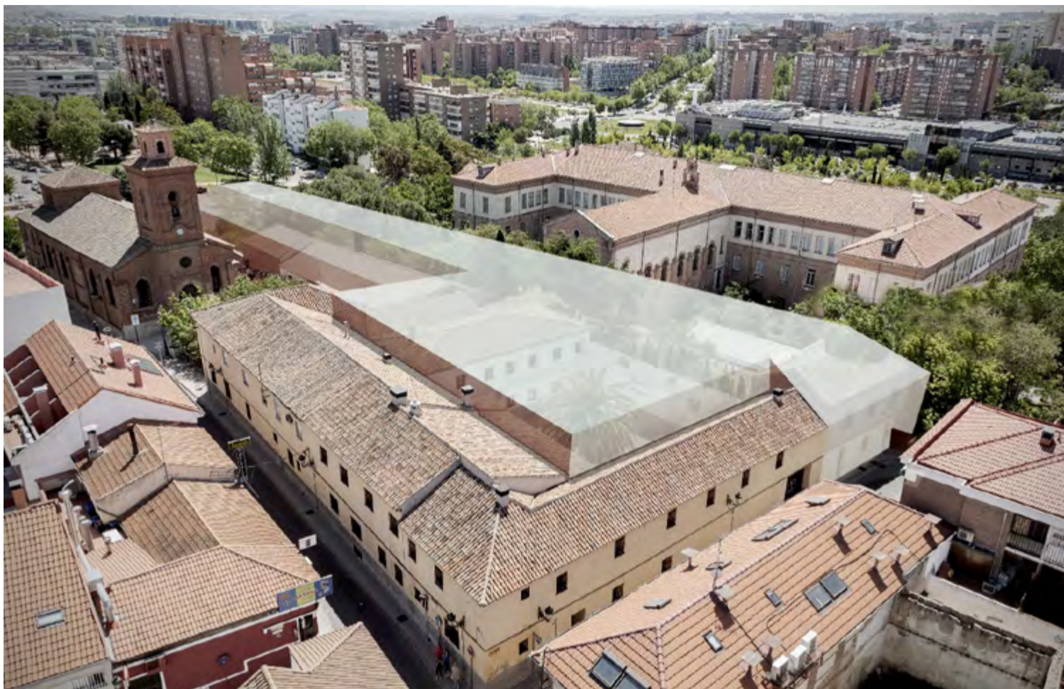
Proyección de la superficie que ocupará el gimnasio en el casco antiguo de Hortaleza.
